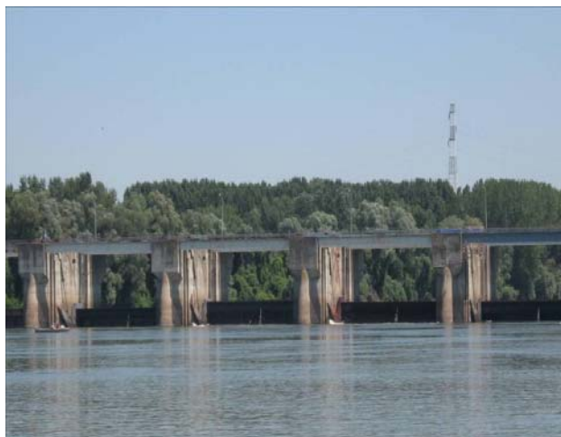
Abb.2: Damm an der Theiss bei Novi Bečej, Serbien. Fig. 2: Dam on Tisza River near Novi Bečej, Serbia. Photo: T.Jurca.
